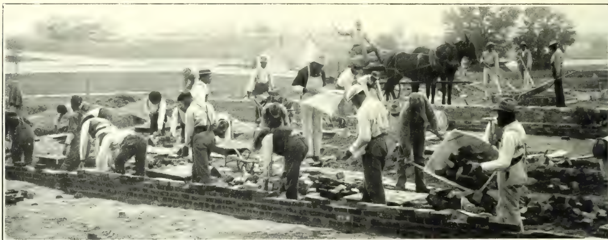
A TUSKEGEE. Les Maçons. — Toute la main-d'œuvre employée à Tuskegee est fournie par les élèves. Chaque bâtiment nouveau dont s'augmente l'école est, en totalité, construit par les pensionnaires.
